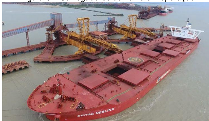
Figura 6 – Carregadores de navio em operação
