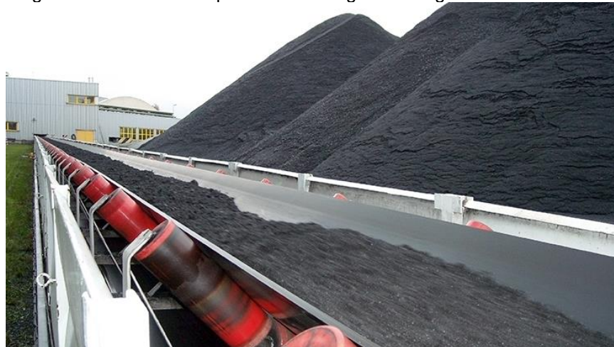
Figura 3 – Correia transportadora carregada com granel sólido
