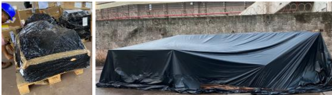
Figura 14 e 15 – Disposição de lona e soerguimento da carga do piso.
