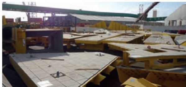
(d) Peças soltas no pátio com revestimento asfáltico.
