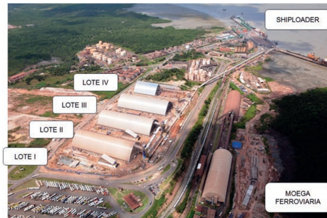
Figura 9 – Vista aérea dos quatro armazéns e moega ferroviária em construção
