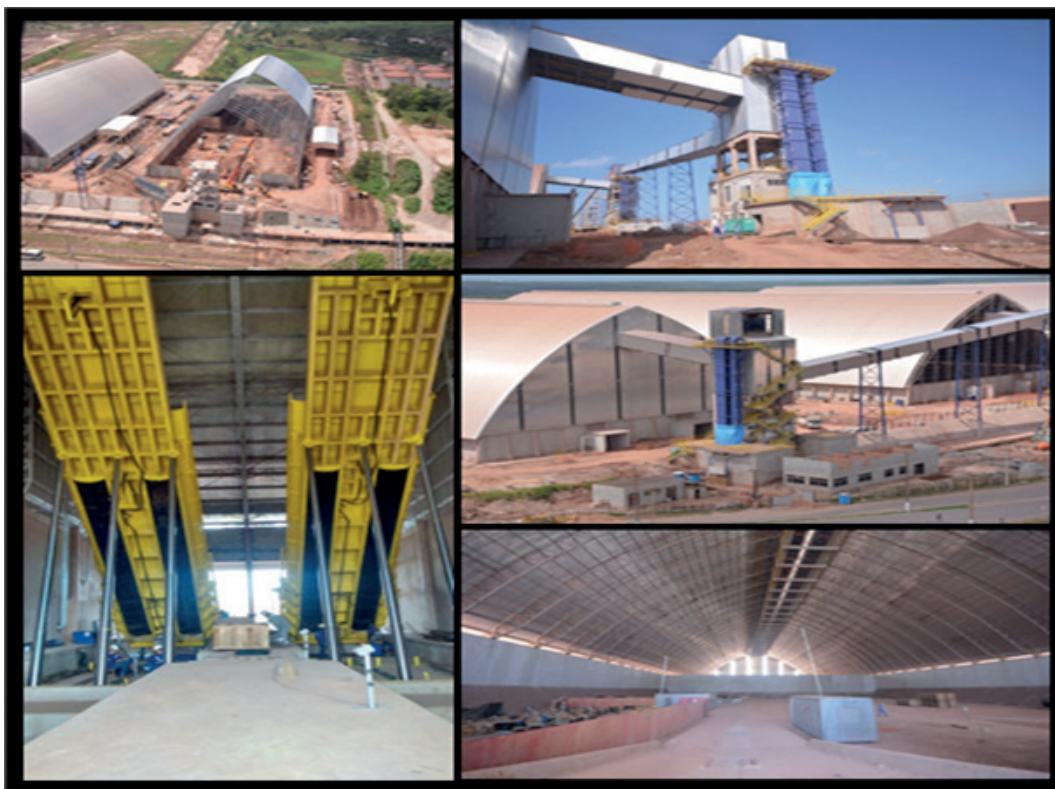
Figura 10 – Vista interna do armazém, tombadores e transportadores
