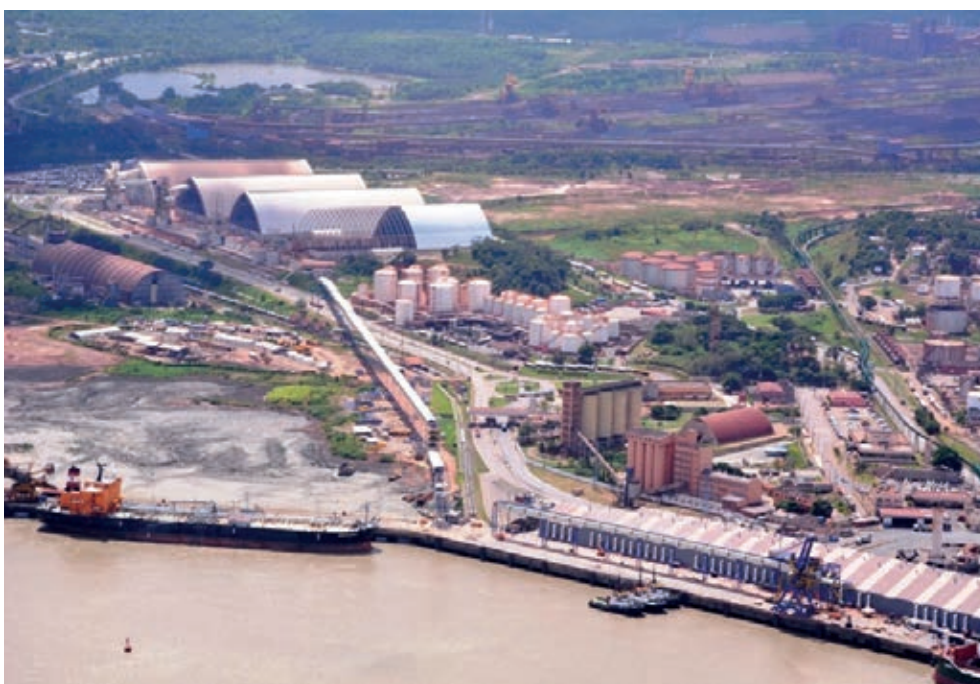
Figura 5 – Vista aérea da construção do TEGRAM
