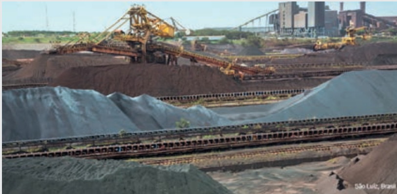
Figura 2 – Vista do pátio de estocagem
