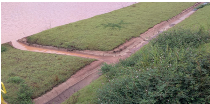
Figura 1 - Entrada do Efluente
