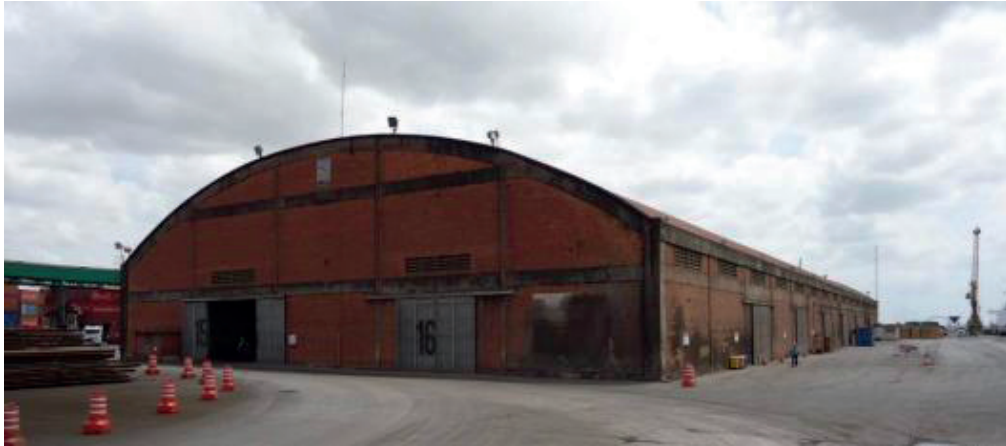
Figura 9 - Armazém na retro área do berço 102.
