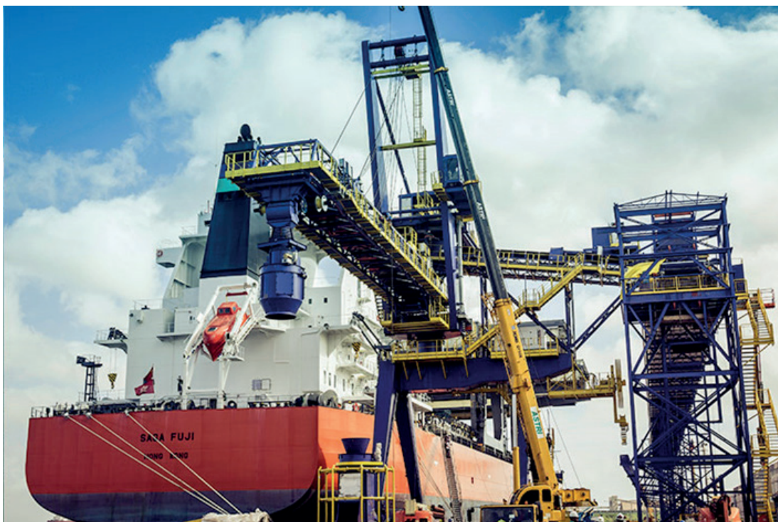
Figura 7 – Instalação do Carregador de Navios no berço 103 do Porto de Itaquí
