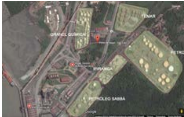
Figura 6. Área de tancagem do Porto do Itaqui
