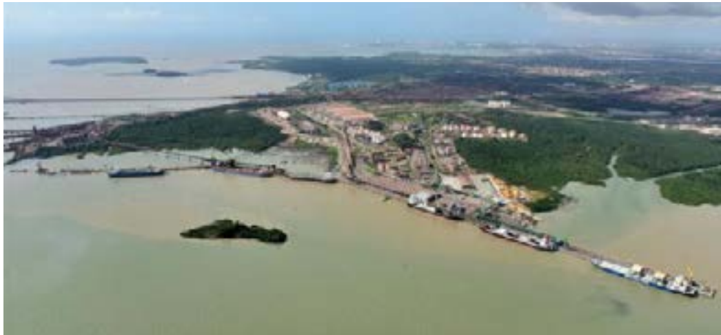
Figura 1 - Vista aérea do Porto do Itaqui
