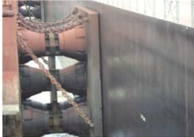
Figura. 8 – Esforço nas defensas com navio completamente carregado.
