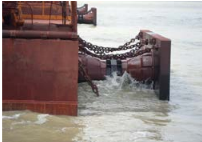
Figura. 6 – Defensas instaladas nos Dolphins de atracação.
