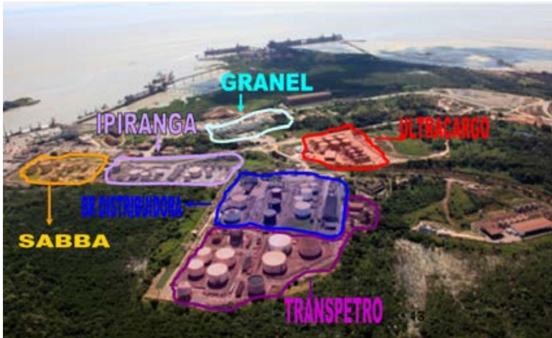
Figura 2 - Vista dos Terminais de Granéis Líquidos e Bases Distribuidoras.
