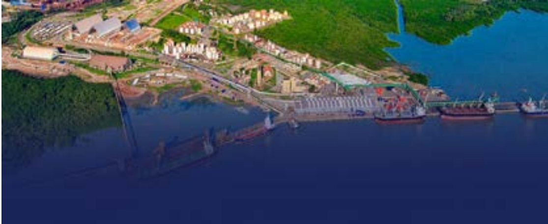
Figura 01 - Vista aérea do Porto do Itaqui.
